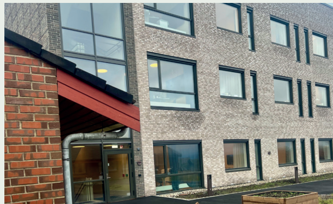
Nybygget har teglsteinsfasade, men i et langt mer moderne uttrykk enn det opprinnelige bygget, til venstre.
